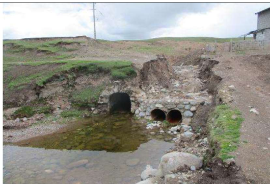
Fotografía 2: Alcantarillas que se obstruyen con las maximas avenidas de la quebrada Huashanragra.
